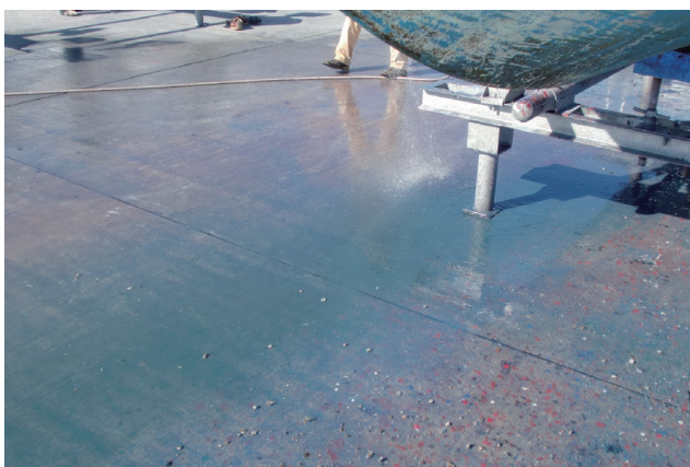
他社加水分解型 高圧洗浄後
